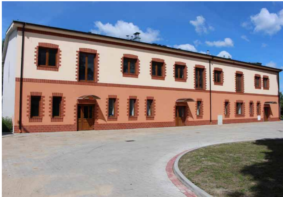
Aus einem alten Stallgebäude wurde eine moderne Wäscherei, in der Menschen mit Behinderung arbeiten werden.
